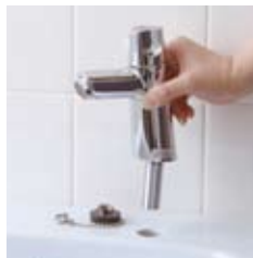
水栓の取り外し
